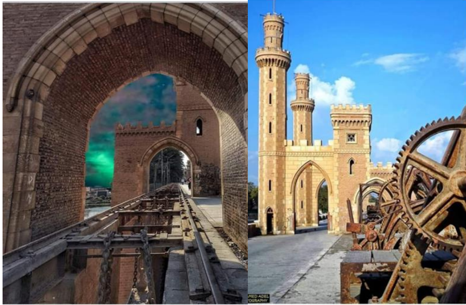
شكل (5) القناطر الخيرية بمحافظة القليوبية -نقلا عن إدارة تفتيش آثار غرب القاهرة.
